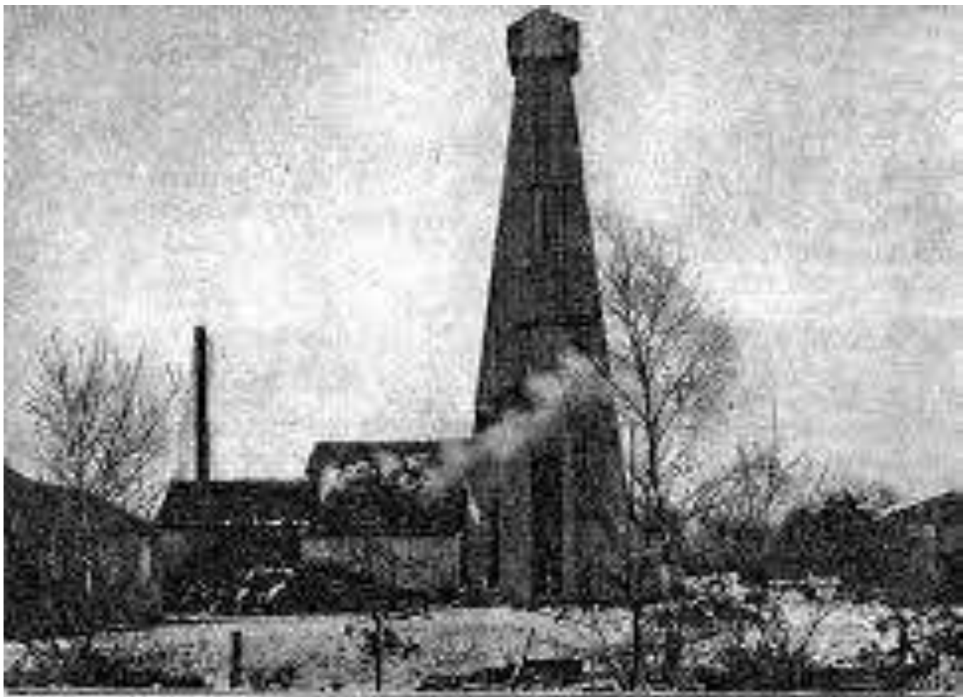
De aardolieput te Corle bij Winterswijk. Het is te hopen, dat men hier inderdaad een winstgevende bron van petroleum heeft gevonden, die in de toekomst van groot belang voor ons Land zal zijn. Bovenaanzicht foto brengt des beoelers in beeld.
